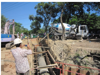
水道管敷設工事現場
