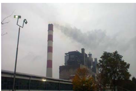
ニコラテスラ火力発電所A
