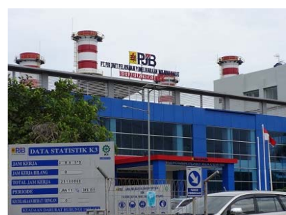
ジャカルタの発電設備視察時
